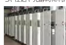
高効率貫流ボイラー。複数の小型ボイラーを効率よく稼動させることで運転効率を向上させる。
